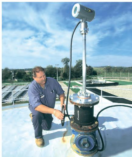
**Рис. 4. При использовании скользящего волновода радарный уровнемер можно установить, эксплуатировать, проверять и обслуживать без разгерметизации резервуара**
