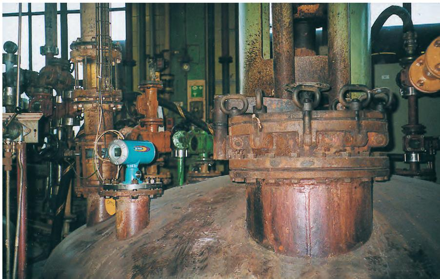
Рис. 1. Исполнение точек доступа внутрь резервуара (патрубки, стояки и трубы) определяет, какие приборы могут быть применены, а также способ и место их монтажа
