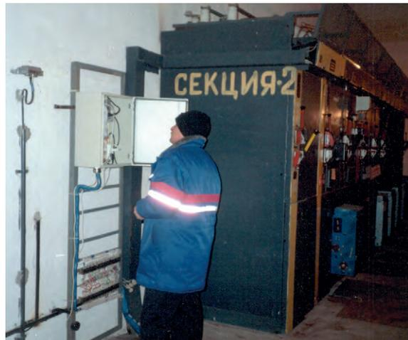
Рис. 9. Разработанные на базе устройств MicroPC контроллеры успешно эксплуатируются в условиях неотапливаемых помещений РП
