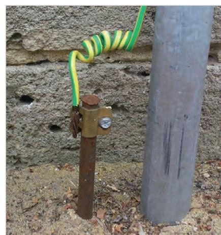
Рис. 10. Устройство заземления для электропастуха
