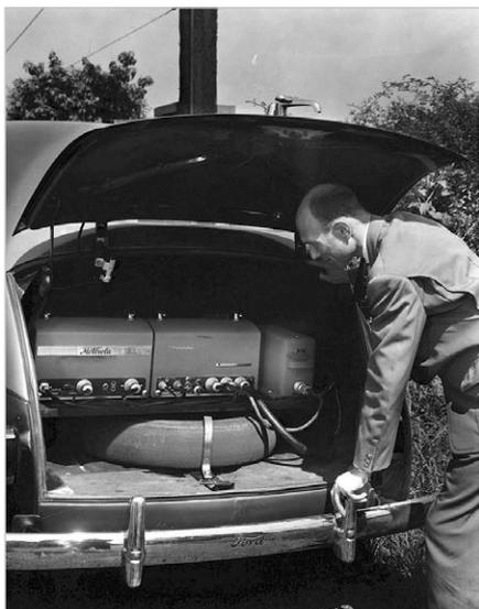
Рис. 15. Оборудование фирмы Motorola для радиотелефонной связи в легковом автомобиле
