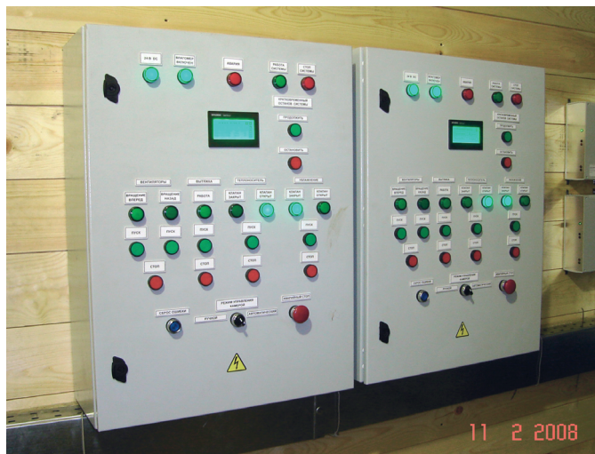
Рис. 1. Внешний вид шкафа автоматизации ША-ЛСК-04
