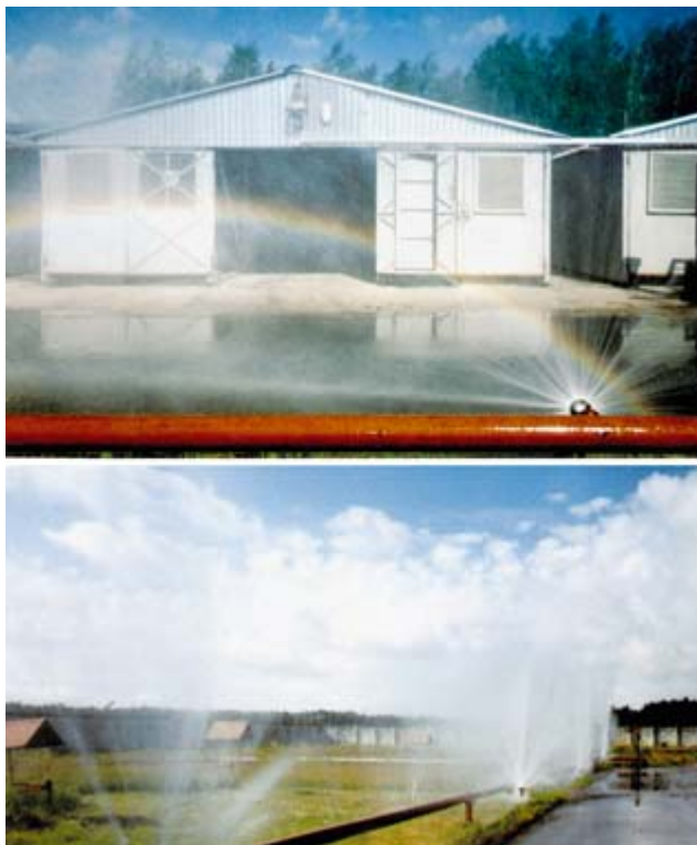
Рис. 10. Пуск водяной завесы при проведении испытаний АСУ ВЗ
