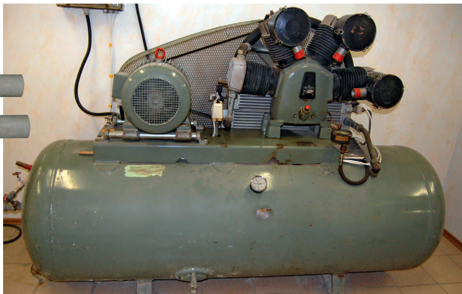
Рис. 5. W-образный компрессор пневмолинии с ресивером
