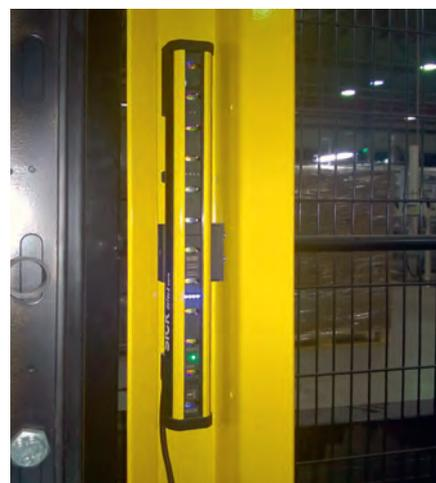
Рис. 5. Приёмник светового барьера безопасности
