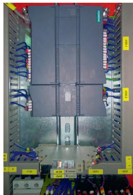
Рис. 6. ПЛК SIEMENS S7-1200 с модулями расширения
