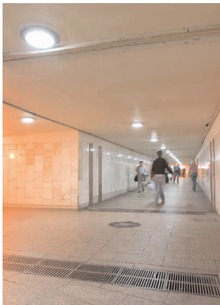
Рис. 3. Освещение подземного пешеходного перехода около станции метро «Рижская» (г. Москва) светильниками на основе светодиодов Cree (прямо) и натриевых ламп высокого давления (слева)
