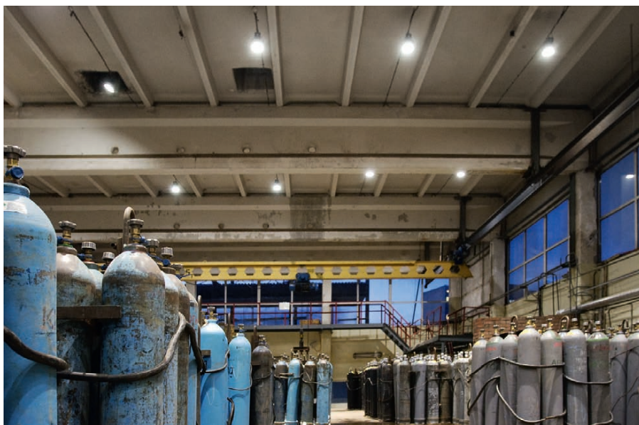
Рис. 8. Освещение цеха предприятия «Логика» (г. Москва, Зеленоград) промышленными светильниками XLight на основе светодиодов Cree
