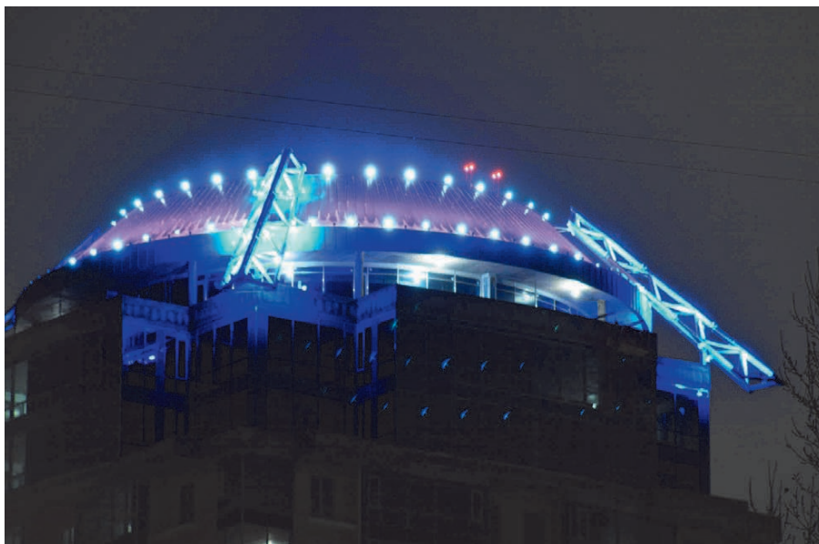
Рис. 4. Подсветка жилого комплекса «Кутузовская Ривьера» (г. Москва) прожекторами на основе светодиодов компании Cree
