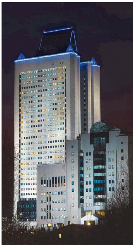
Рис. 2. Освещение светильниками на основе светодиодов Cree здания ОАО «Газпром» (г. Москва)
