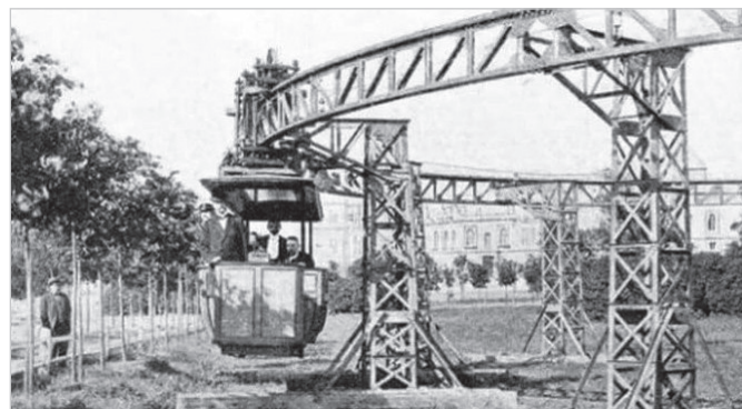
Рис. 7. Электрическая железная дорога на монорельсе конструкции Романова
