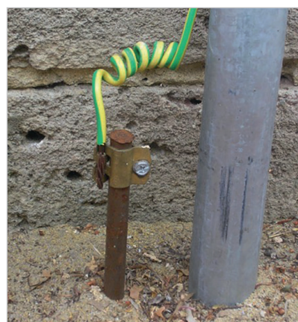
Рис. 10. Устройство заземления для электропастуха
