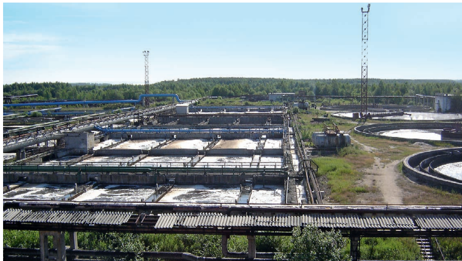
Рис. 1. Общий вид территории станции биологической очистки
