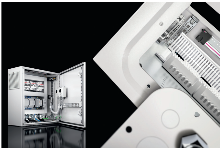
Рис. 16. Установка оборудования на кронштейны двери корпуса
