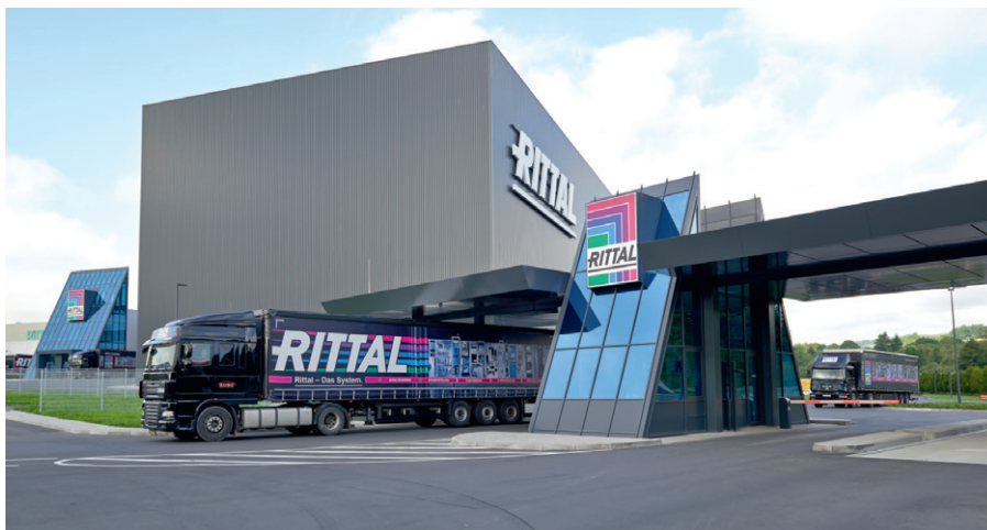
Рис. 1. Завод Rittal в г. Хайгер
