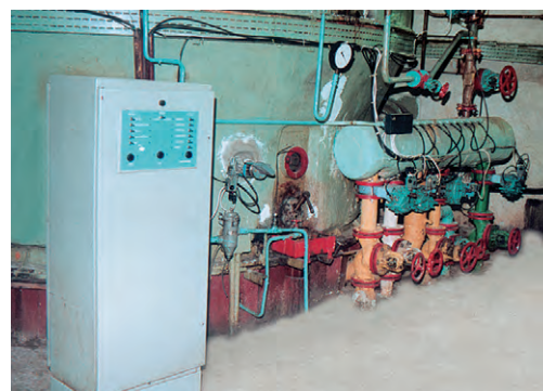
Датчики и исполнительные устройства системы автоматизации вакуум-аппарата
