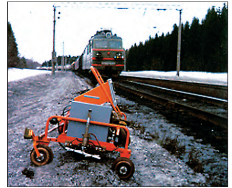
Рис. 3. Эвакуация дефектоскопической тележки при приближении поезда
