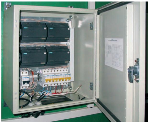
Рис. 7. Монтаж блока БП-240
